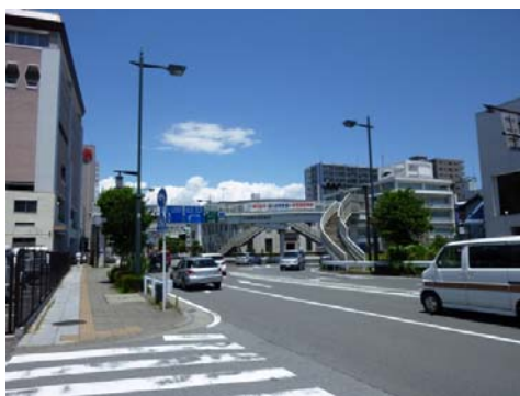
図-23 国道1号の様子
