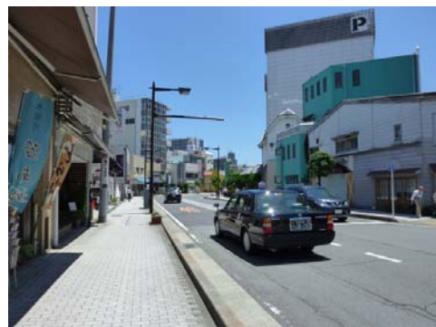
図-24 国道255号の様子
