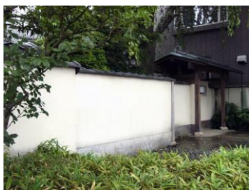
モルタル塗の上、仕上げを施した塀の例
