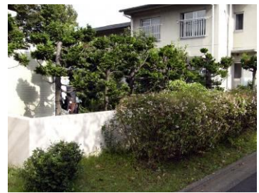
前面に植栽を施した擁壁の例
