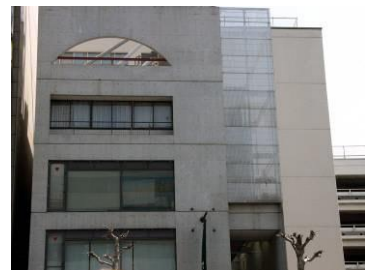
建築設備をルーバーにより修景した例
