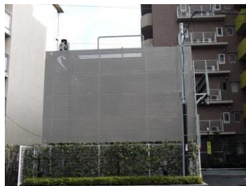
ルーバーにより修景した立体駐車場の例
