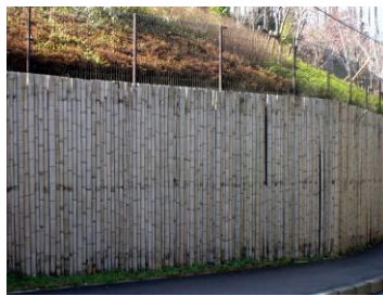
前面に竹を施し修景した擁壁の例
