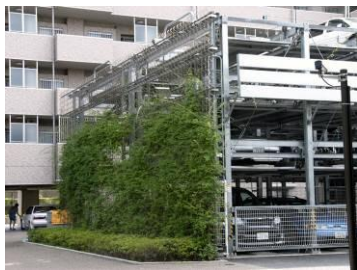
ツタ等により修景した立体駐車場の例
