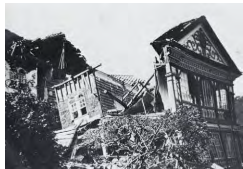
関東大震災により倒壊した洋風建築
