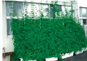
公共施設壁面緑化
