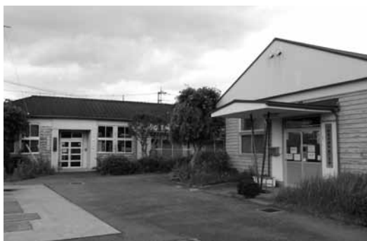
▲豊川支所(手前)と豊川分館(奥)
