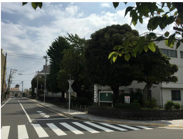
小田原法務合同庁舎と横浜地方裁判所 小田原支部(中心部)
