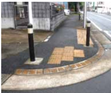
車止め (交差点等に設置)
