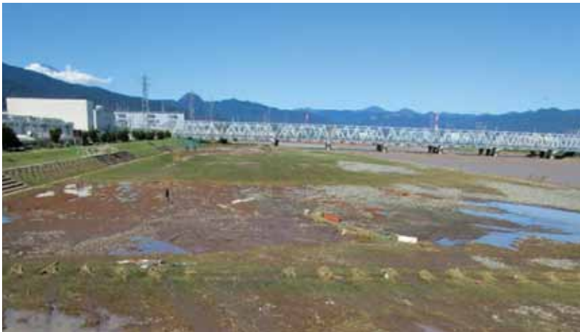
▲酒匂川スポーツ広場 グラウンドは水でえぐられ、バックネット等の設備の倒壊・流失、流木等の漂着といった被害があった。
