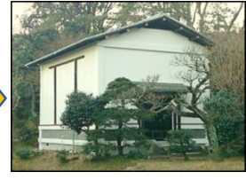
■収蔵庫 外壁 漆喰補修(既存撤去・塗り直し)
