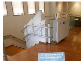
■別館 段差解消機設置
