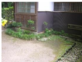
■老櫓荘 外壁 トタン張から杉皮張に復元修景
