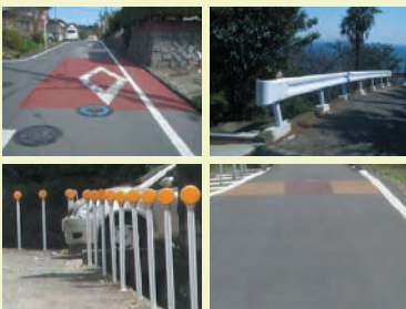
道路舗装や安全施設の整備
