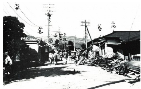
3-2 関東大震災直後の国道1号
