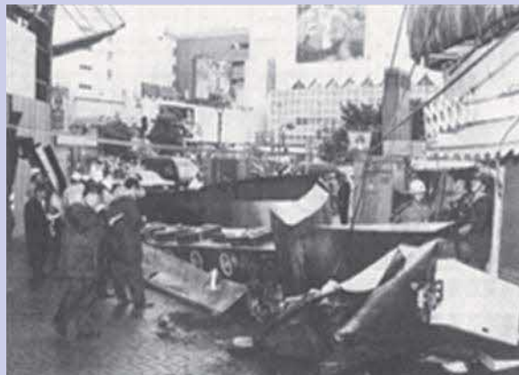
台風で落下した時の様子
