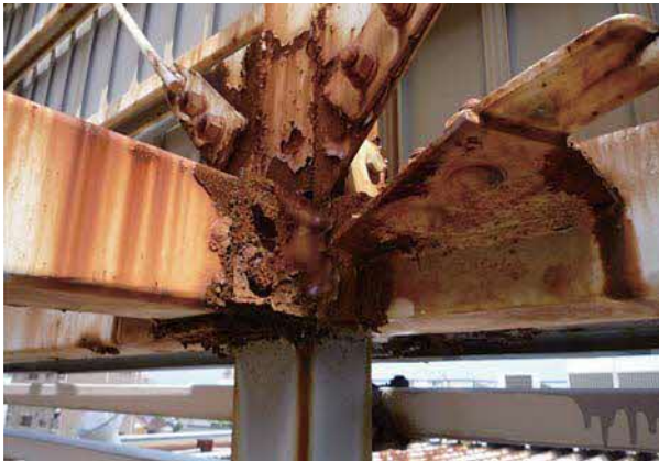
老朽化した屋上広告塔の骨組みは、サビによる腐食でボロボロに。もしも落下したら…
