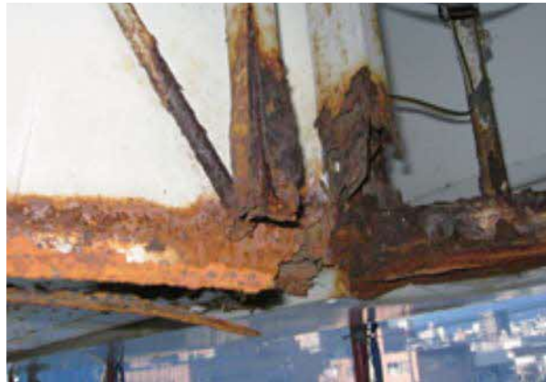
老朽化した屋上広告塔の骨組みは、サビによる腐食でボロボロに。もしも落下したら…
