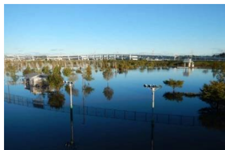
公園と一体となった遊水地が台風時に河川の水を貯留し災害を防止するなど、気候変動に伴う災害の激甚化・頻発化への対応に貢献
