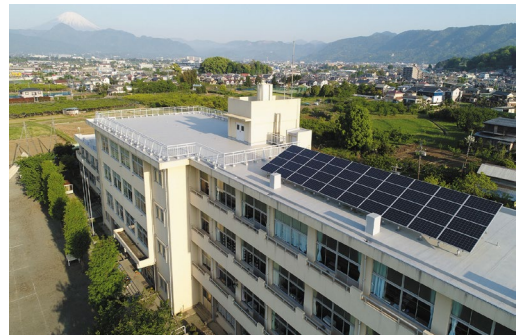
市内小学校に設置した太陽光パネル
