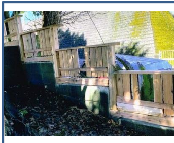
工事中(研修中)の様子
