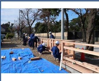
工事中(研修中)の様子
