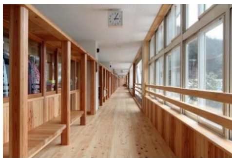
学校施設全体を木質化 （兵庫県村岡小学校）
