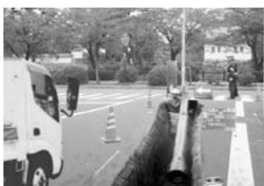
老朽管の耐震化工事
