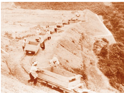
トラックで土砂を運ぶ労働者(城山陸上競技場)
