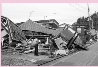
新潟県中越地震の被害状況
