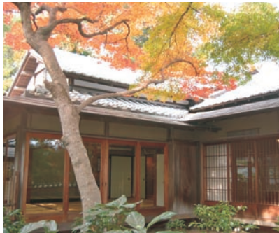
老樗荘(国登録有形文化財)1946年、耳庵が埼玉県柳瀬(現所沢市)から移り住んだ際に建築しました。
