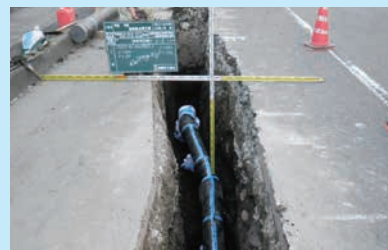
水道管路耐震化工事
