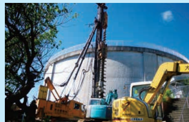
配水池耐震補強工事
