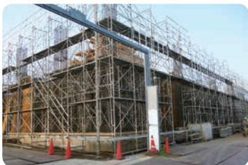
薬品注入施設工事
