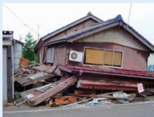
倒壊した住宅
