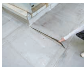
防水シートの破れ
