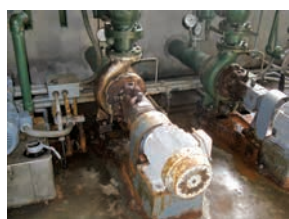
ポンプの腐食
