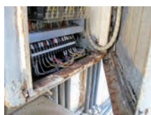
設備カバーのさび
