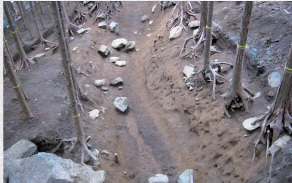
わだちが残る石曳道(神奈川県教育委員会提供)
