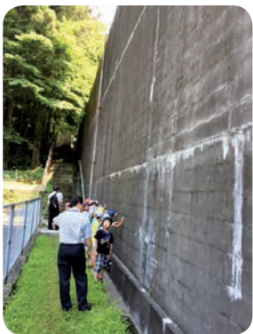
ブロック塀の向こう側が埋立処分場
