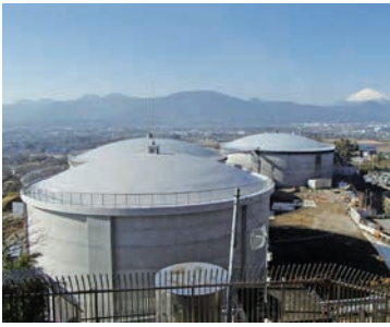
中河原配水池 手前が3号配水池、右奥が1号配水池
