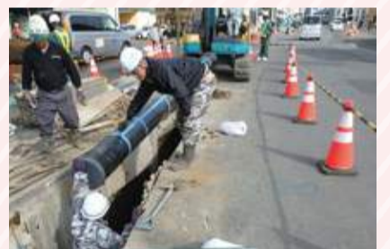
道路・上下水道などのインフラ整備を推進
