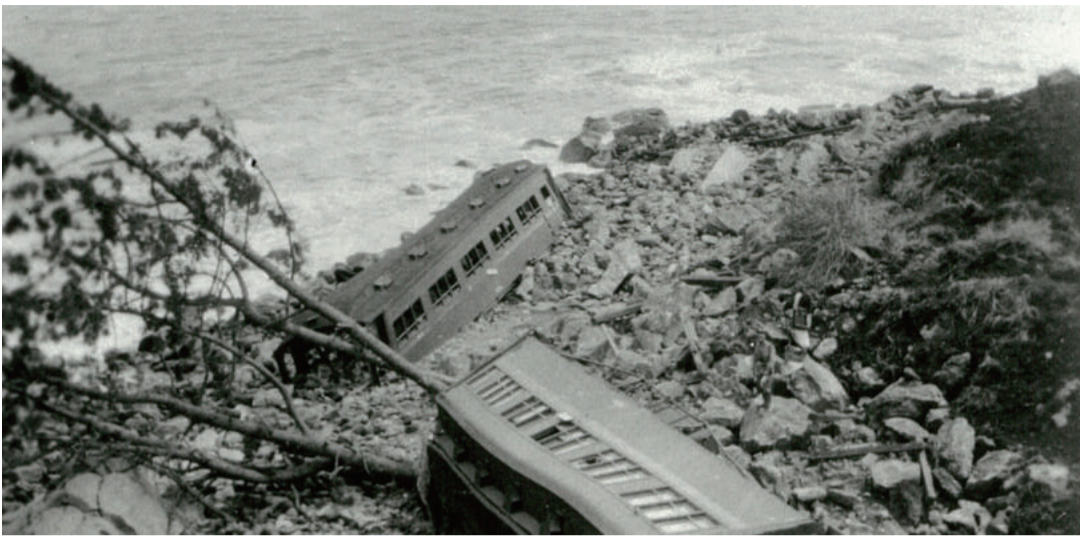
▲山津波により、根府川駅から波打ち際まで転落した列車
