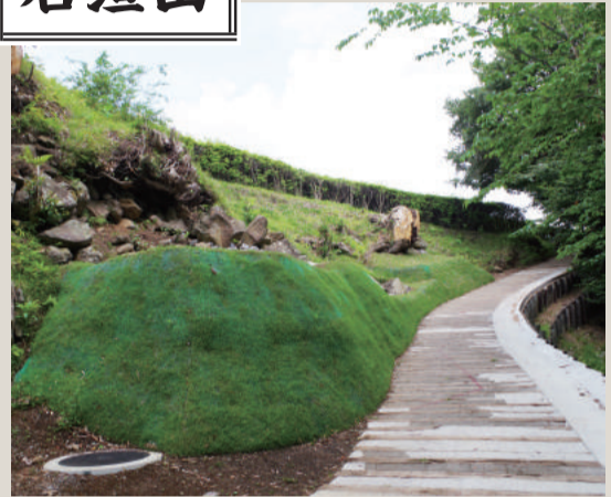
▲平成28年度整備箇所
