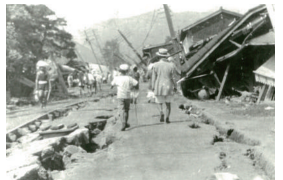
▲至るところに地割れが入った道路(現在の南町付近)
