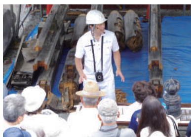
▲第1回保存修理工事見学会のようす
