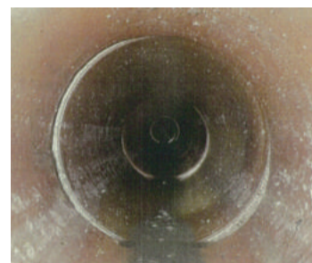
古くなった下水道管
