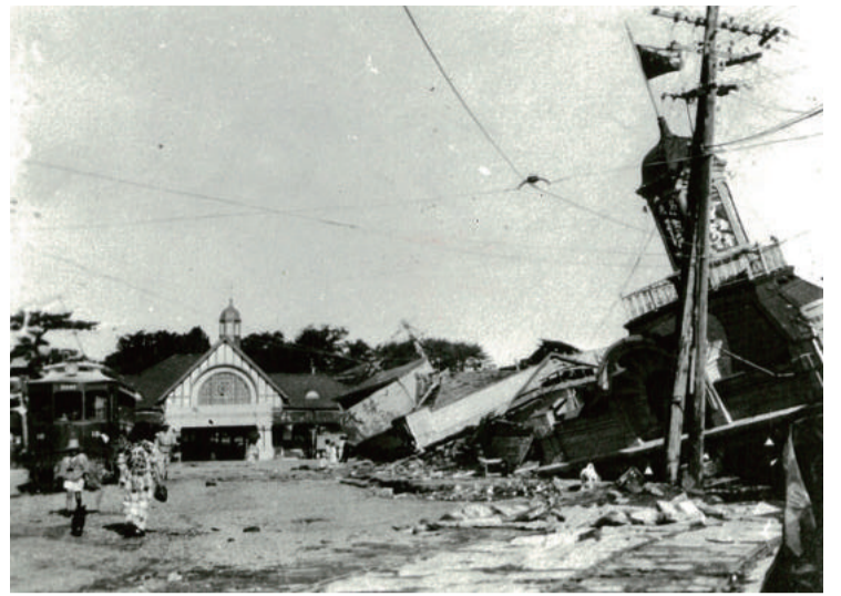
▲倒壊した駅舎と周辺建物(小田原駅前)
