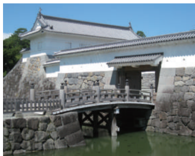
▲保存修理工事前の住吉橋
