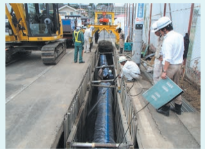
耐震型の水道管に入れ替えているようす
