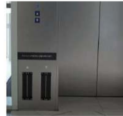
K エレベーター 上腕に障害のある方のためのフットスイッチを設置している。
