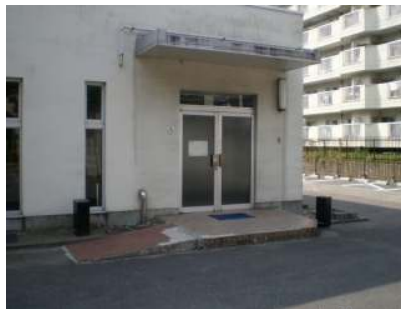
楽屋入口改修
