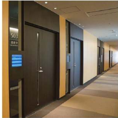
J 出入口 主要な部屋の扉位置が分かりやすくなるよう、床や壁のデザイン、照明を工夫している。また壁と床の境がはっきりするよう、床端部と巾木を濃色としている。各室の出入口にも情報案内画面が組み込まれている。
