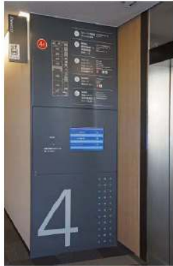
I エレベーターホールの案内表示 聴覚障害者等に配慮し、非常時の情報等も表示できる、情報案内画面が組み込まれている。
