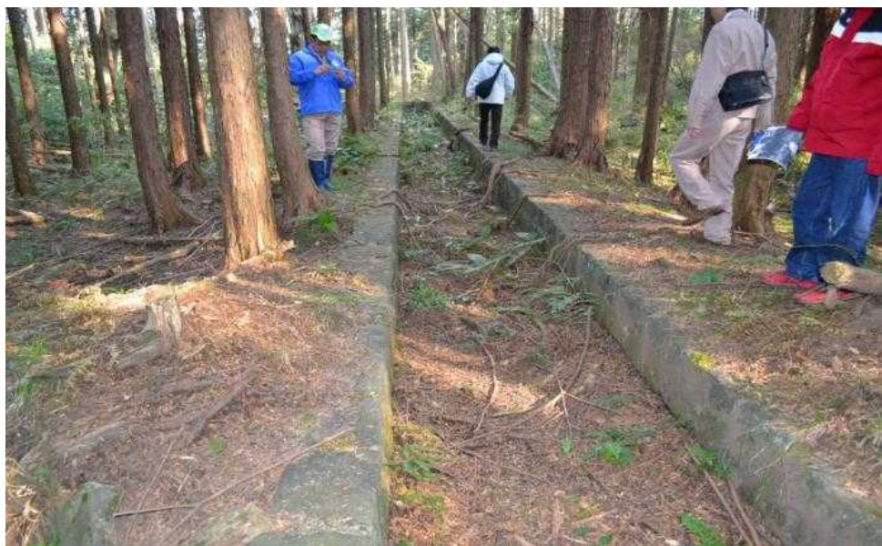
小水力発電所遺構
