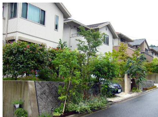
擁壁の前面を植栽した例
