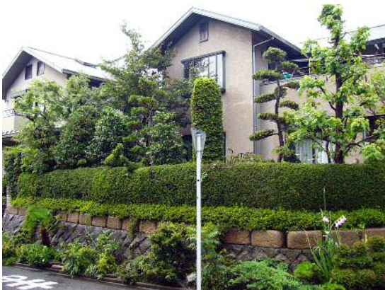
化粧型枠等により仕上げられた擁壁の例
