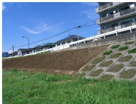
作業後の様子
