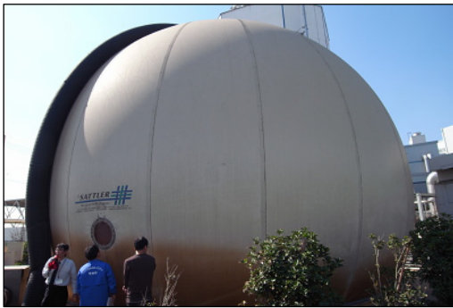
メタンガス貯留槽（球状のもの）と余剰ガス処理装置（円筒状のもの）
