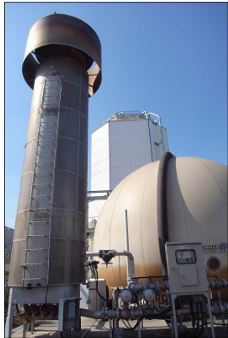
メタンガス貯留槽（球状のもの）と余剰ガス処理装置（円筒状のもの）
