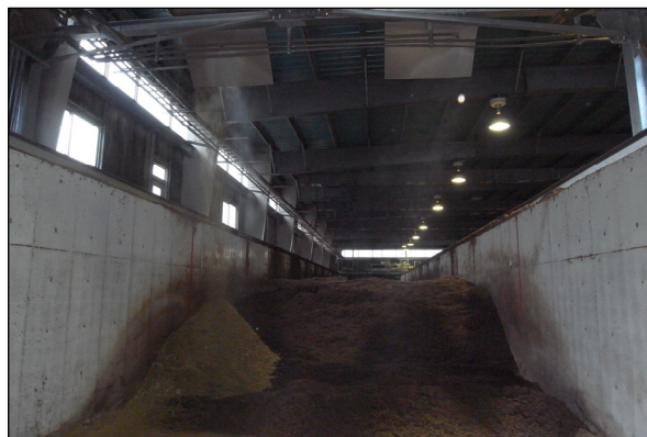
写真 3 堆肥化プラント（町田市）
