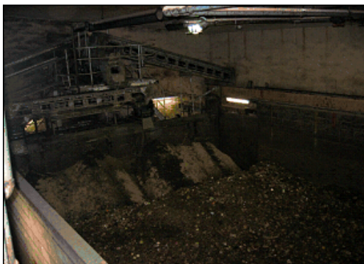
一次発酵槽に生ごみ・畜ふん・籾殻の3原料が投入され、15日かけてパドルとよばれるブレードで攪拌発酵されます。
