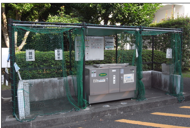
ごみ集積場所に設置された業務用生ごみ処理機
