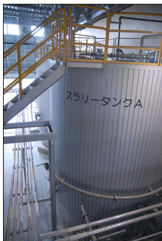
スラリータンク (可溶化槽)
