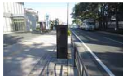
植樹帯と電線共同溝地上機器
