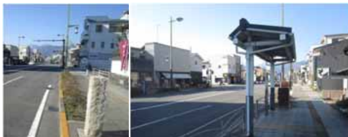
歩道内に植樹帯、照明、バス停、電線共同溝地上機器
