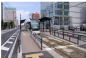
LRT(導入空間、センターホール、電停等)の整備
