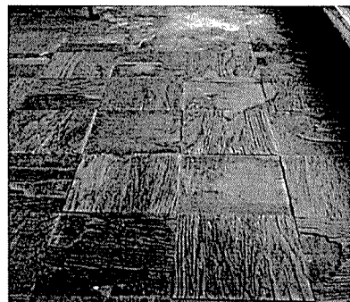
《床の剥がれ・傷み》
