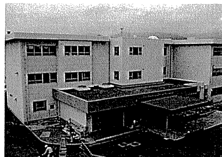
《外壁改修後の白山中学校》
