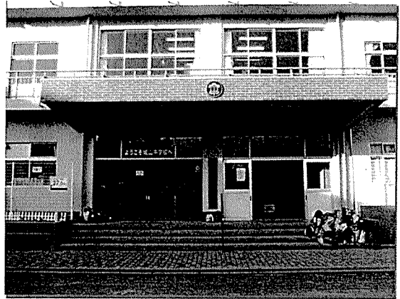
《外壁改修・城山中学校》
