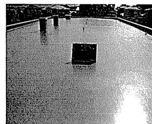
《防水工事施工後》
