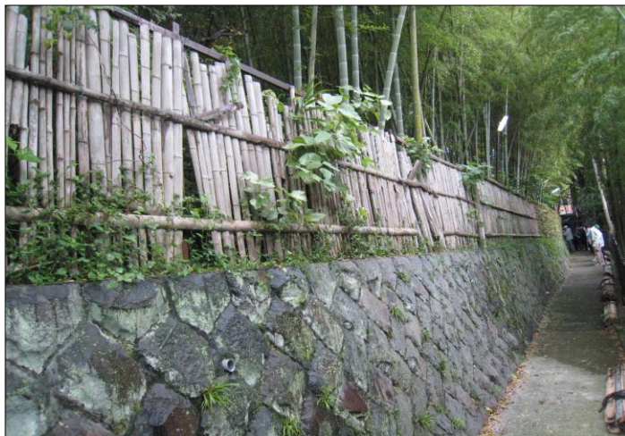
劣化した竹垣(改修前)
