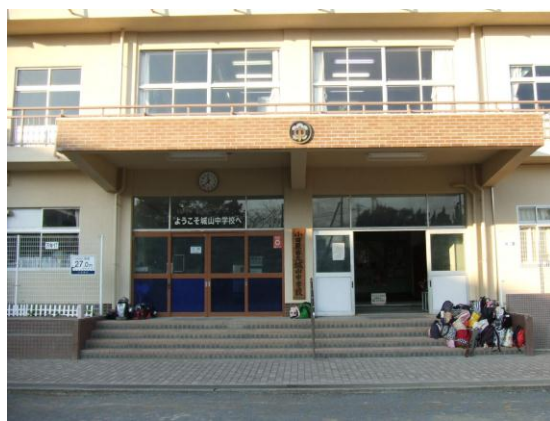
《外壁改修・城山中学校》
