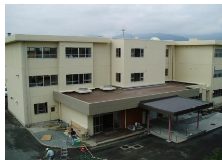
《外壁改修後の白山中学校》
