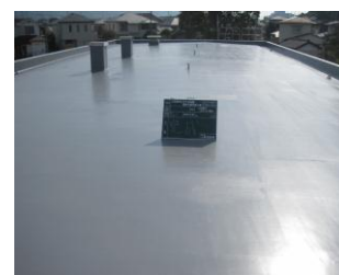
《防水工事施工後》
