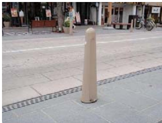
歩車道分離施設（可動式ボラード）
