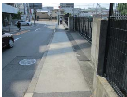
図-67 歩道の波うちの状況（弁財天通り） ※再掲
