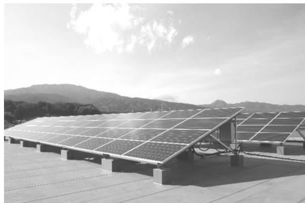
↑ 小学校に設置された太陽光発電システム
