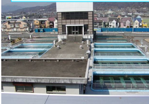
高田浄水場（急速ろ過池）
