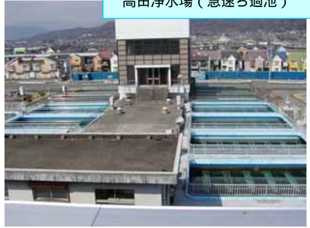
高田浄水場（急速ろ過池）
