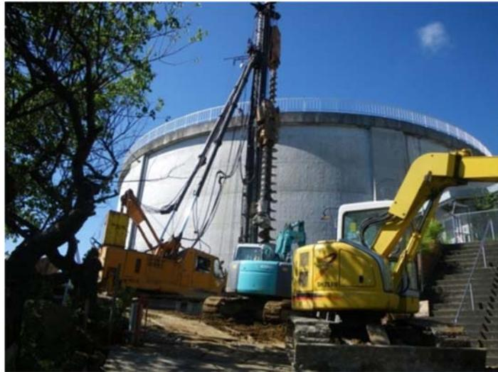
中河原1号配水池の杭の増設による耐震補強
