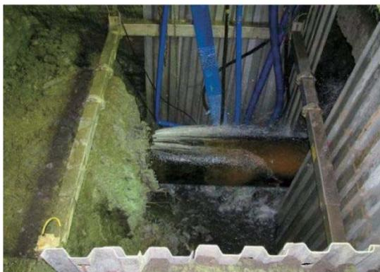
配管継手部からの漏水
