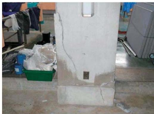
ろ過池支柱の亀裂
