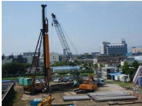
高田浄水場新1号沈でん池杭打ち状況
