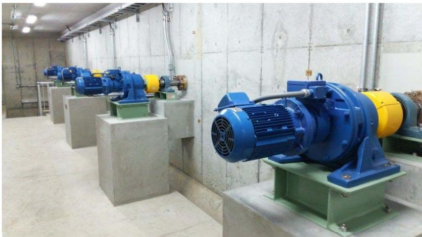
インバーター制御対応モータ（高田浄水場）
