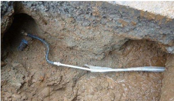
ステンレス鋼管への布設替え状況
