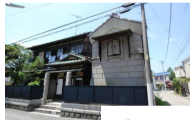
市川邸(早川) 昭和2年建築
