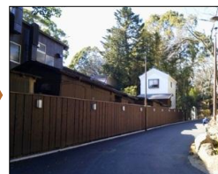
隣地板塀 (施工後)
