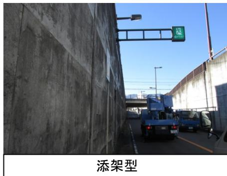
写真 3-9 本市が管理する道路情報提供装置の支柱形式
