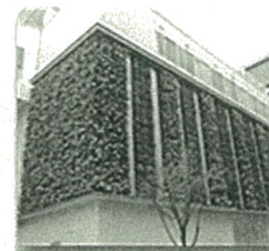
公共施設壁面緑化
