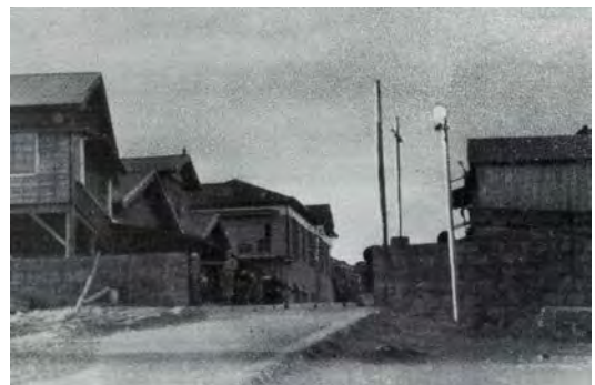
魚市場前の舟揚場と堤防(昭和22年頃)
