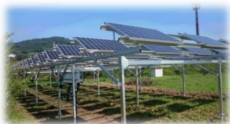
下曽我に設置された営農型太陽光発電設備
