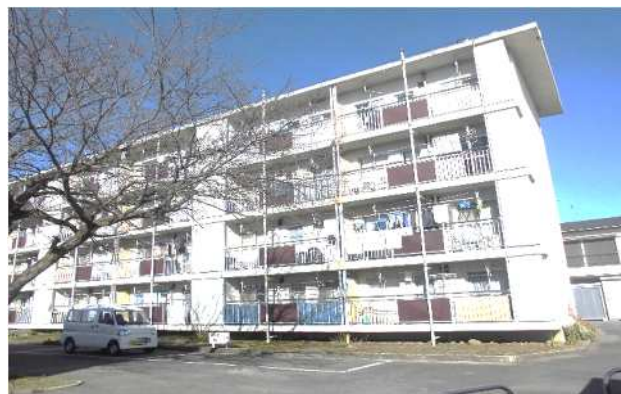
市営久野住宅
