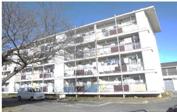
市営久野住宅
